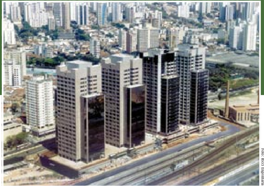
Fundos do empreendimento para a Av. Senador Auro de Moura Andrade, recém-inaugurada
